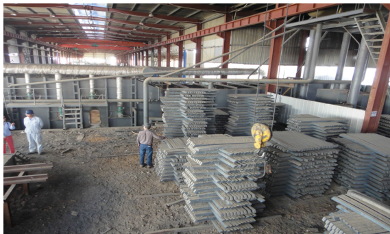
L'intérieur de l'usine
